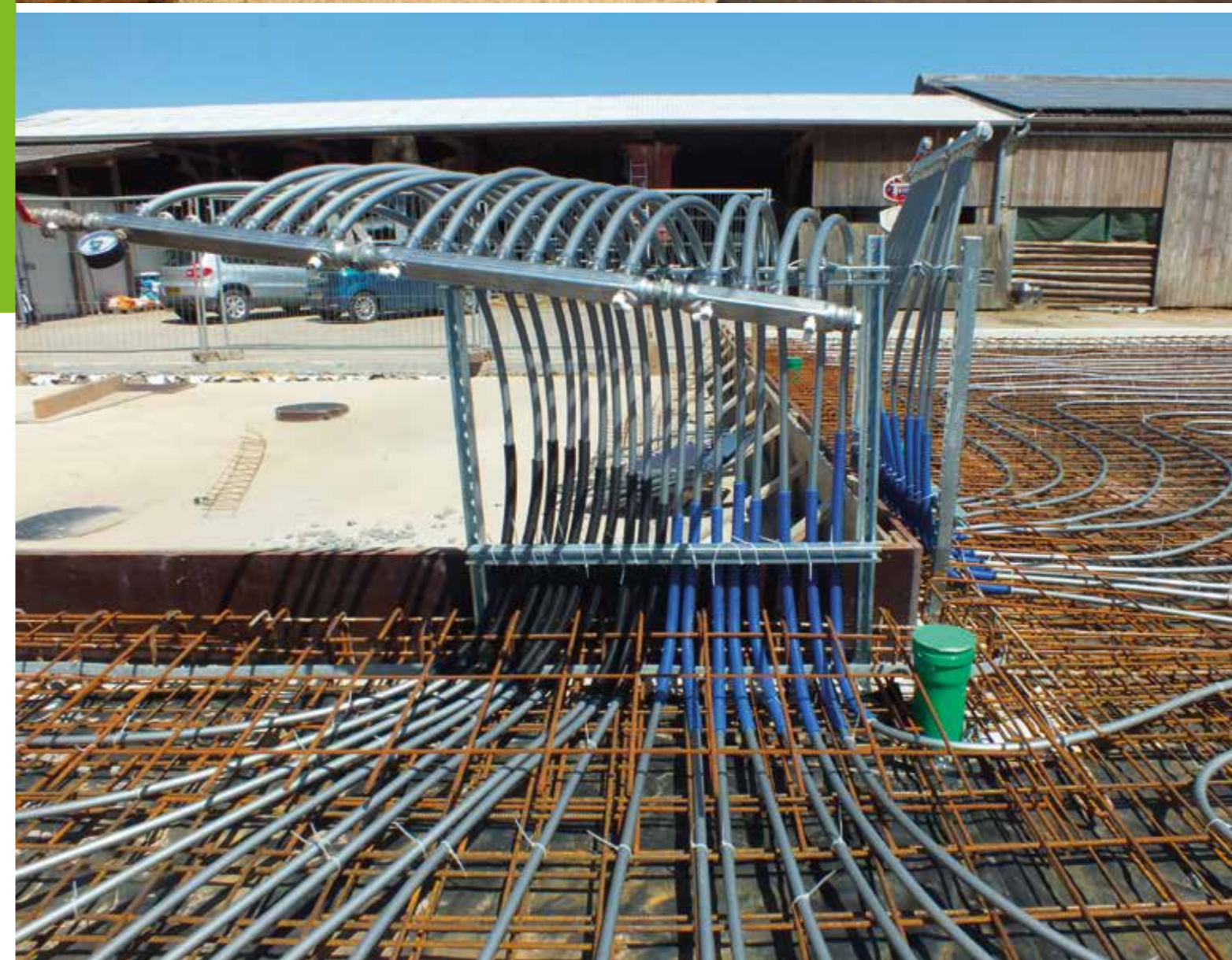
2015 erhielt der Hofladen des Meyers-Haff einen Preis für nachhaltiges Bauen. Dieser würdigte das Wärmetauschsystem zwischen Kühlanlagen und Fußbodenheizung ebenso wie unversiegelte Parkflächen und ökologisches Konstruktionsmaterial.
