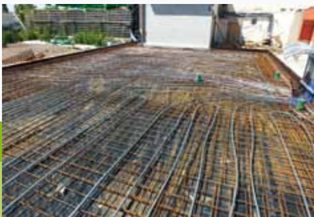
Die Anlage der Fußbodenheizung im künftigen NATURATA-Hofladen auf dem Meyers-Haff verdeutlicht das Prinzip der Betonkern-Aktivierung.
