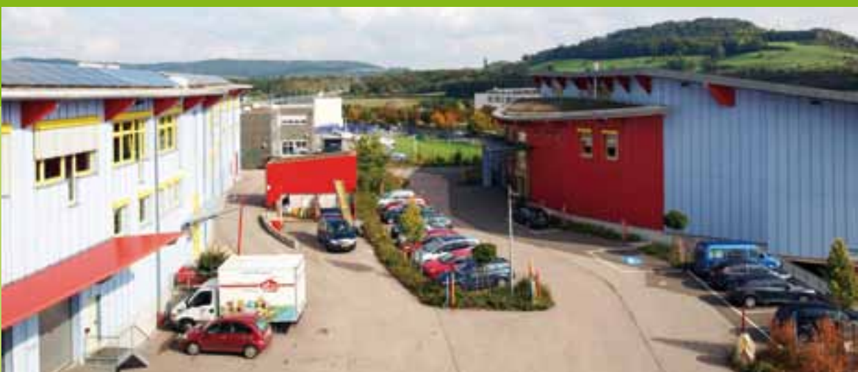
Im OIKOPOLIS-Zentrum Munsbach sind die beiden Gebäude, die für Herstellung (links) und Verbrauch stehen, nicht nur mit den Mitteln der Architektur harmonisch aufeinander bezogen.
